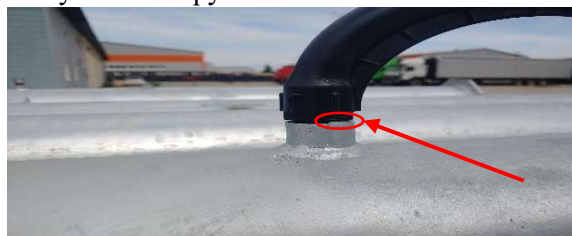
Рисунок 3 - способ установки отводов
